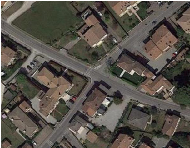
stato di fatto (Intervento 7-A)
